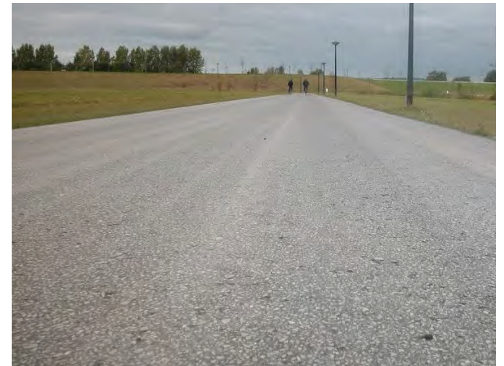
asfaltering met bestrijking
