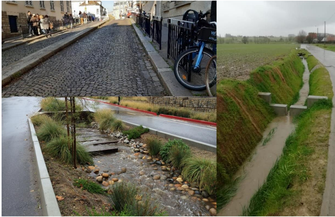
Figuur 6. Vlnr en vbno: (1) verhoogde borduren van voetpaden in Parijs (© Aquafin); (2) doorvoer waterloop in groenberm straat (© svrdesign.com) en (3) gracht met bufferschotten (© Kruisem).
