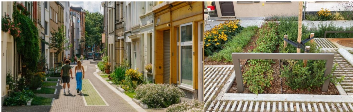
Figuur 2. Vlnr: (1) ontharding met boven- en ondergrondse infiltratie in centrum Antwerpen (© Aquafin); (2) Infiltrerende plantvakken in Aziëlaan (tuinstraat Wilrijk).
